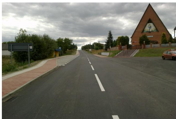
Droga powiatowa 6013 T na odcinku Styków – Jabłonna
