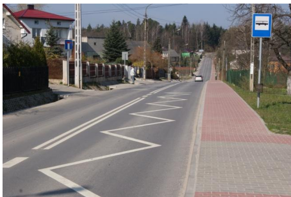
Droga powiatowa nr 0581 T - ul. Nowowiejska w Starachowicach
