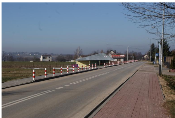
Droga powiatowa nr 0903 T w m. Kałków
