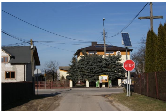
Skrzyżowanie drogi powiatowej nr 0568 T z drogą nr 0567 T w m. Małyszyn – znak aktywny B-20
