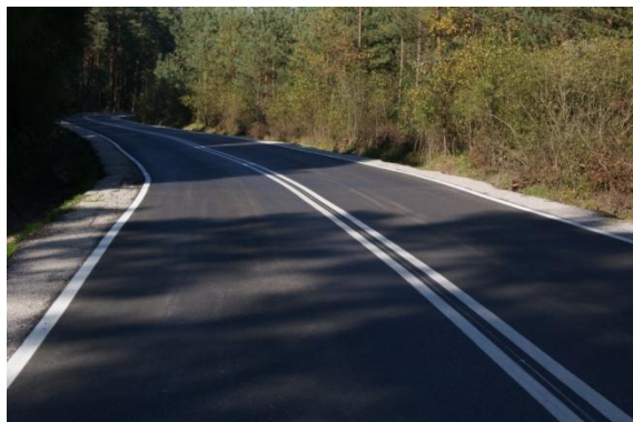
Droga powiatowa nr 0563 T Mirzec – Wąchock
