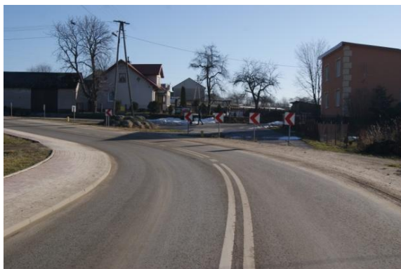
Droga powiatowa nr 0613 T w m. Dąbrowa – korekta łuku - (fotografia przed i po przebudowie drogi).
